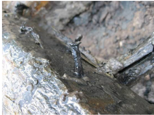
Afbeelding 2.10 De fundering van de waterkelder: a. houten planken van de vlonder; b. dennenhouten dwarsbalk; c. fundering bij het verwijderen van de stenen vloer; d. detail ijzeren nagel in de dwarsbalk.
