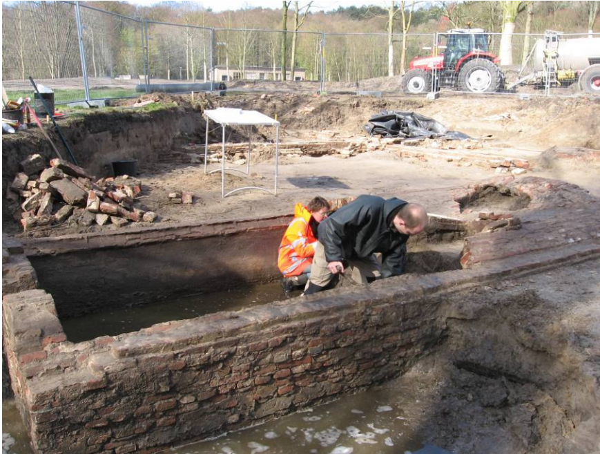
Afbeelding 2.9 Het uitgraven van de waterkelder.
