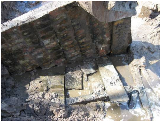
Afbeelding 2.10 De fundering van de waterkelder: a. houten planken van de vlonder; b. dennenhouten dwarsbalk; c. fundering bij het verwijderen van de stenen vloer; d. detail ijzeren nagel in de dwarsbalk.
